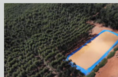
Um dos 32 piscinões da Aperam BioEnergia para armazenamento de água no Vale do Jequitinhonha
