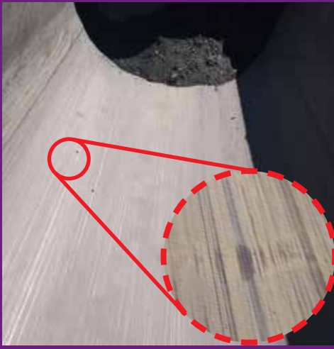
Caçamba em aço ao carbono com agarramento de material e sinais de corrosão e abrasão
