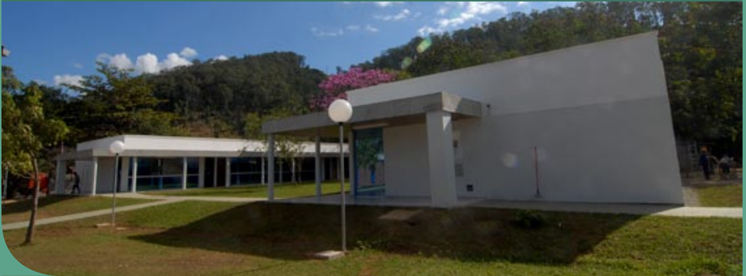
Centro de Formação Profissional: estrutura 100% aproveitada pela ArcelorMittal Inox Brasil
